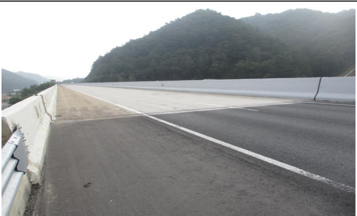
교량 상부 전경
